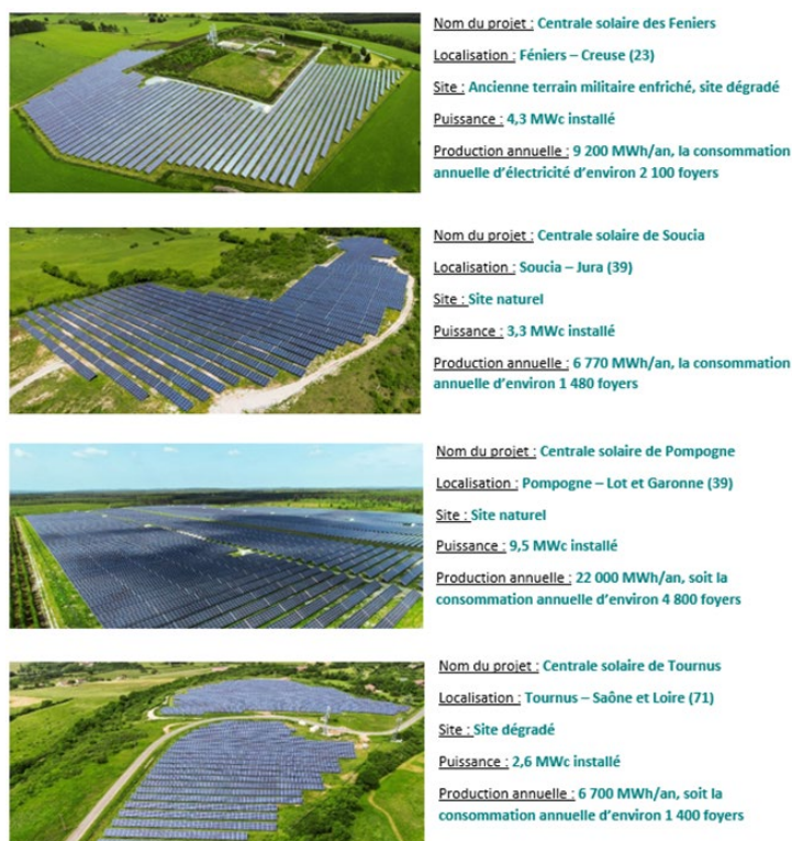
Figure 4 : Exemples de parcs photovoltaïques exploités par SMEG en France (Source : SMEG)
